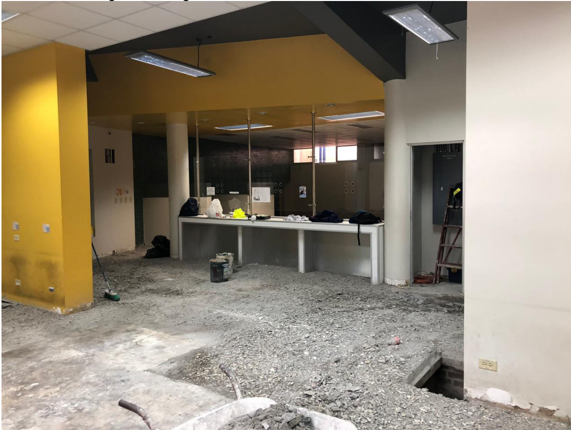
Imagen 3. Fotografiada la remodelación de la biblioteca, 2019.
