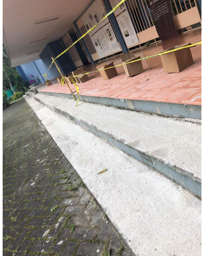
Imagen 2. Fotografías del reemplazo de las baldosas de la entrada principal, 2019.
